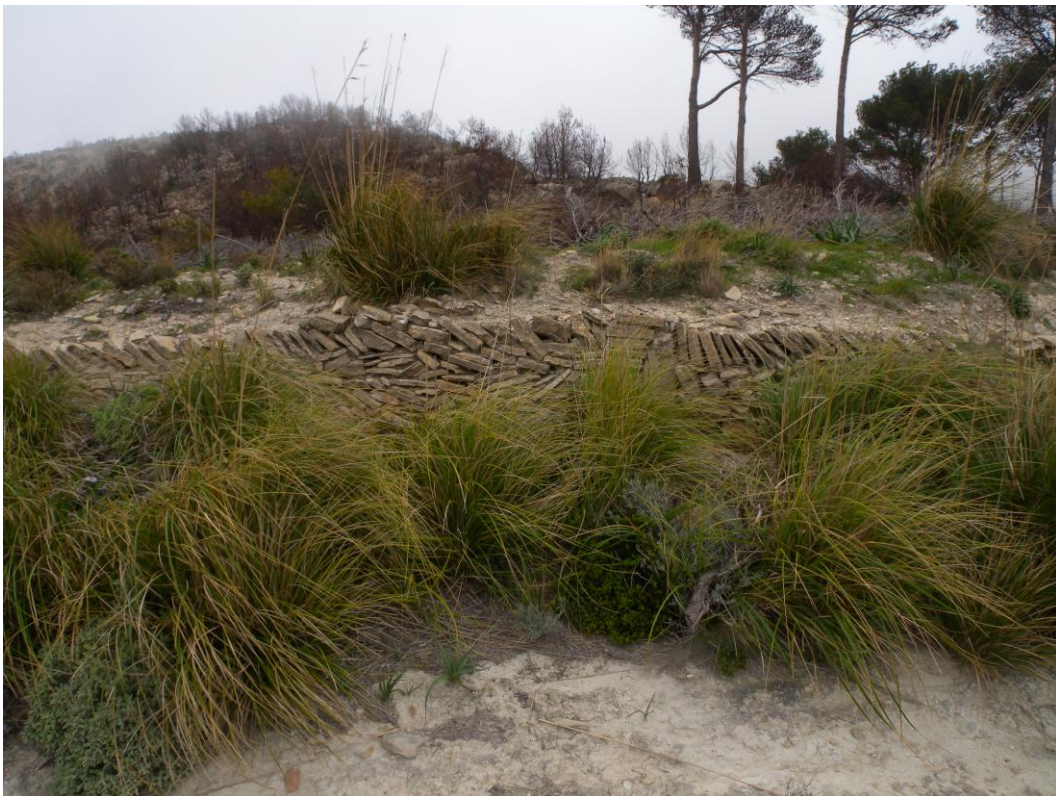
Paret abandonada de lloses calcàries, amb carritxeres a la base Fotografia: G. Alomar Garau
