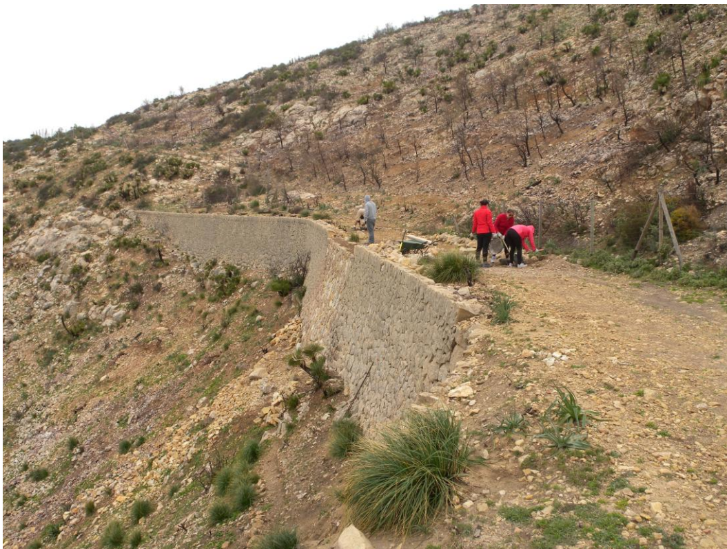
Treballs de reparació d'un marge de contenció. Mestre marger: Antoni Torrens Fotografia: G. Alomar Garau
